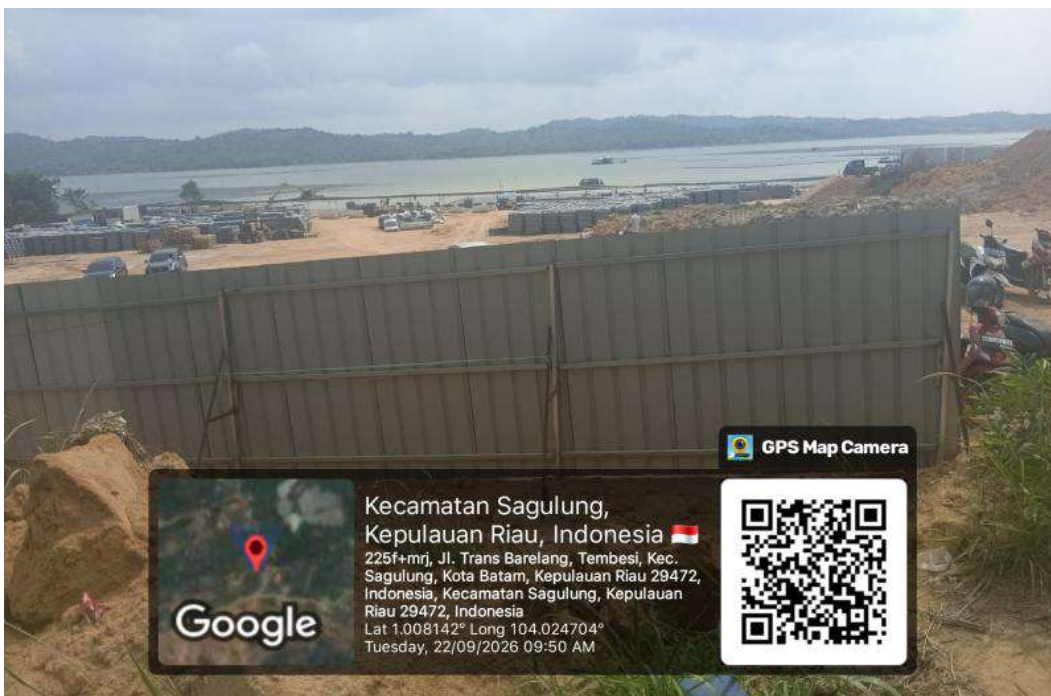
Gambar 9. Dokumentasi Progres Pembangunan PLTS Waduk Tembesi
