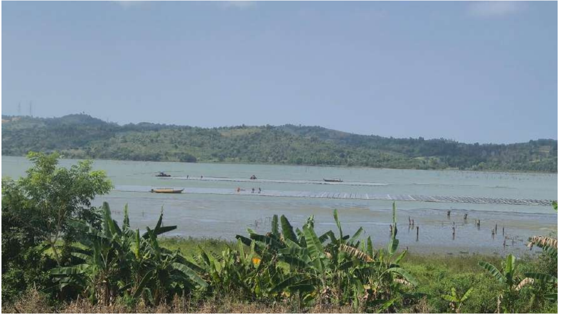
Gambar 7. Dokumentasi Proses Konstruksi PLTS Tembesi
