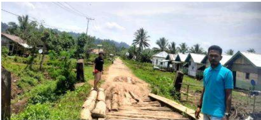
Jembatan di Desa Trans Weley, yang rusak akibat banjir, dan sulit dilewati mobil atau angkutan lain, kecuali sepeda motor. (Sumber: Tim Peneliti)
